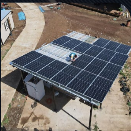
Sistema Ongrid 12kW Trifásico - Talca
